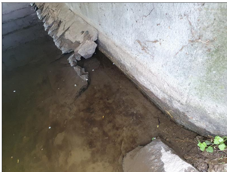
Porušené opevnění
