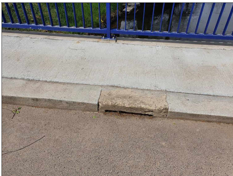
Nefunkční odvodňovače
