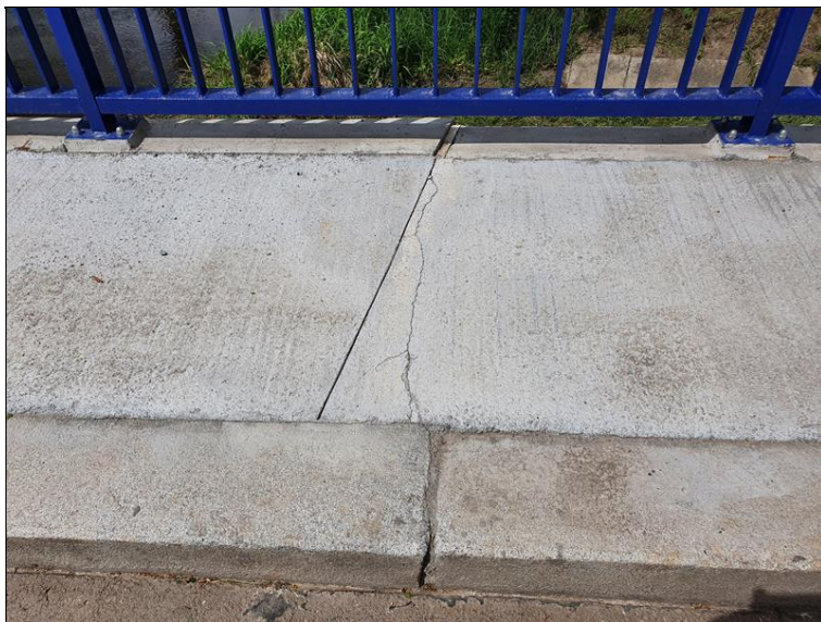
Trhliny na chodníku
