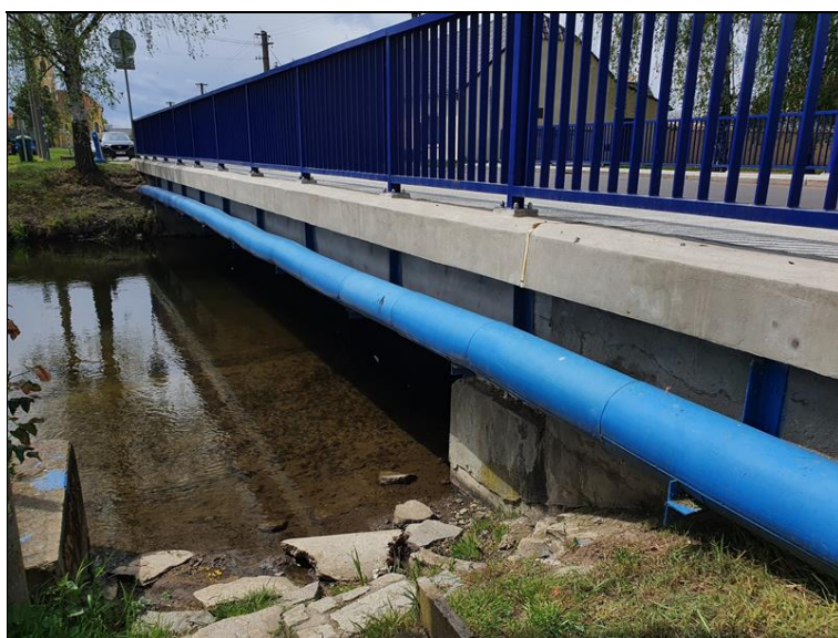
Převáděné potrubí
